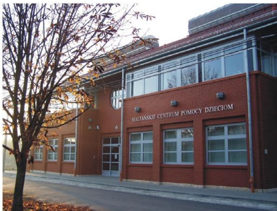
Kraków, ul. Kasztanowa 4a
